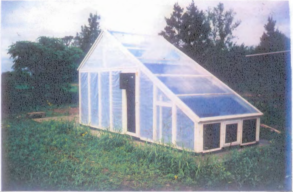
Bild E.1a: Einfache solare Holztrocknungsanlage des Centro de Investigación de la Madera y Afines (CITEMA) in Santiago del Estero, Argentinien; Ansicht von Nordost auf Trocknungskammer und Kollektor
