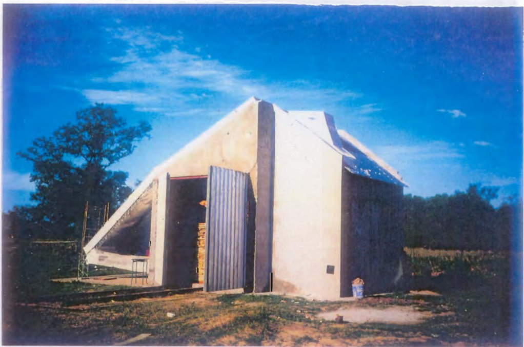
Bild E.2b: Solare Holztrocknungsanlage mit Zwangskonvektion der Grupo de Investigación en Tecnologías Energéticas Apropriadas (G.I.T.E.A.) in Resistencia, Argentinien; Blick auf die geöffnete Trocknungskammer
