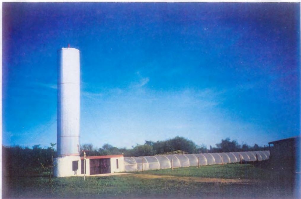
Bild E.3: Solare Holztrocknungsanlage mit natürlicher Konvektion der Grupo de Investigación y Desarrollo de Energías Renovables (G.I.D.E.R.) in Resistencia, Argentinien; Blick auf die Anlage
