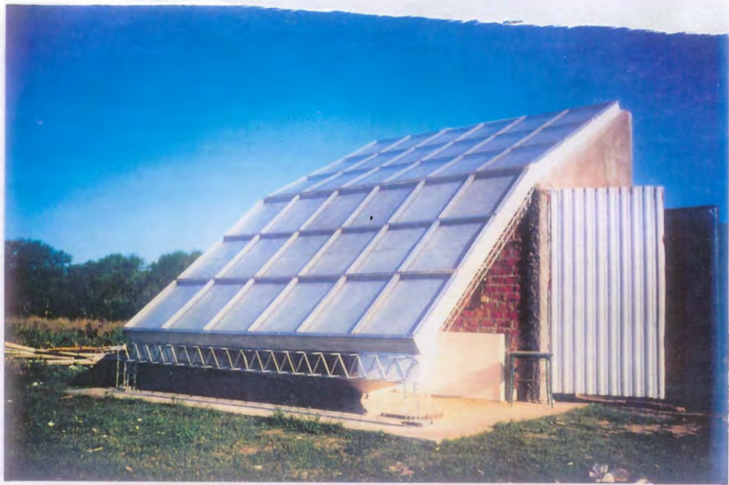
Bild E.2a: Solare Holztrocknungsanlage mit Zwangskonvektion der Grupo de Investigación en Tecnologías Energéticas Apropriadas (G.I.T.E.A.) in Resistencia, Argentinien; Blick auf den Kollektor
